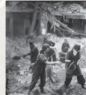
1945 Wiederaufbauarbeiten in Wien
